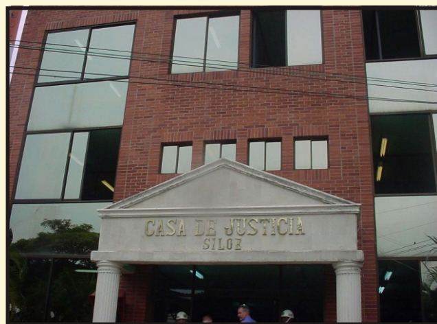
Casa de Justicia en Siloé, Cali
